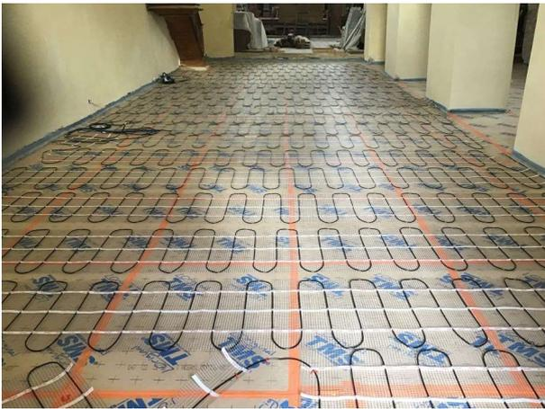
Après l'installation du chauffage au sol dans la nef, les tomettes sont en train d'être posées.
