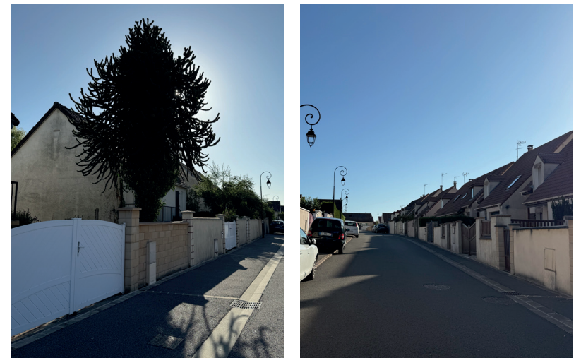
MURS DE CLÔTURES RUE JEAN MOULIN ET RUE DE LA VALLÉE
